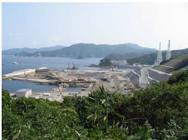
建設中の3号機。右は1・2号機の排気塔
