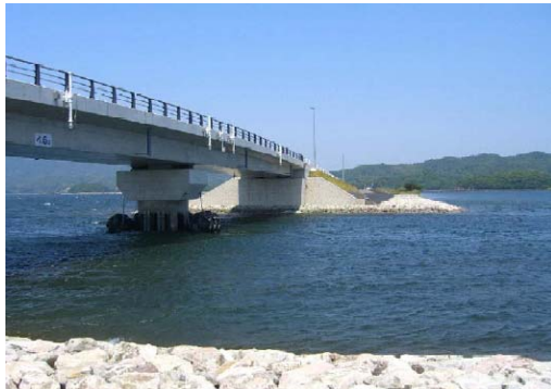
28年ぶりに潮の出入りが 始まった森山堤防開削部 (宍道湖中海汽水湖研究 所HPより)
